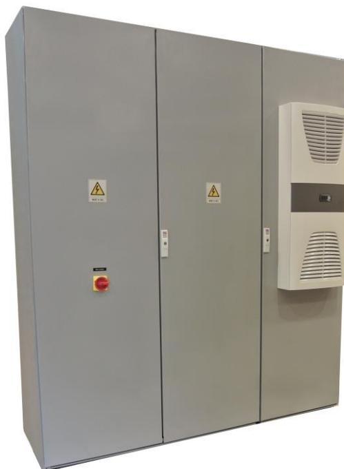
Die Funktion des Schaltschranks Z-8002 besteht darin, alle Anlagenteile der Prozessstraße mit Strom zu versorgen. Der Schaltschrank steuert den Betrieb aller Anlagenteile der Prozessstraße und schützt auch elektrische Antriebe vor Beschädigungen bei Überlastung.
